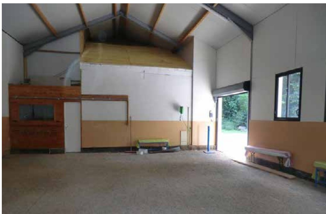
Extension du bouleodrome couvert avec panneaux photovoltaïques sur la toiture
