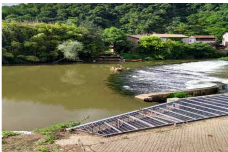
la passe à poisson en amont du pont, côté Viaur
